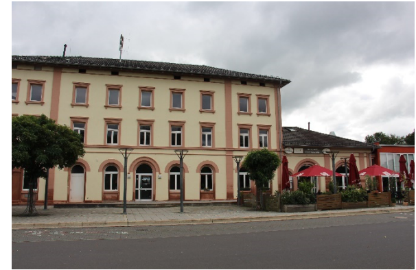
Hauptgebäude mit Westflügel ohne Obergeschoss, mit rotem Restaurant-Anbau. Rundbögen symmetrisch zum Ostflügel, dort sind sie allerdings unterteilt.
