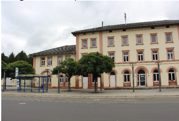
Hauptgebäude und Ostflügel mit Obergeschoss.
