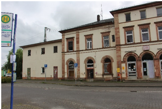
Ostteil des Hauptgebäudes mit schmucklosem Ostflügel. An der Stelle dieses schmucklosen Ostflügels befand sich ursprünglich der später abgebrochene fürstliche Empfangsraum. 3
