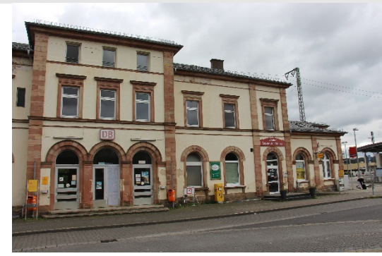
Symmetrisches Hauptgebäude mit vorkragendem Mittelrisalit und Westflügel
